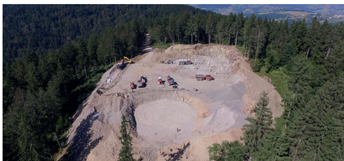
Chantier du parc éolien de Gersbach dans la Forêt-Noire.
